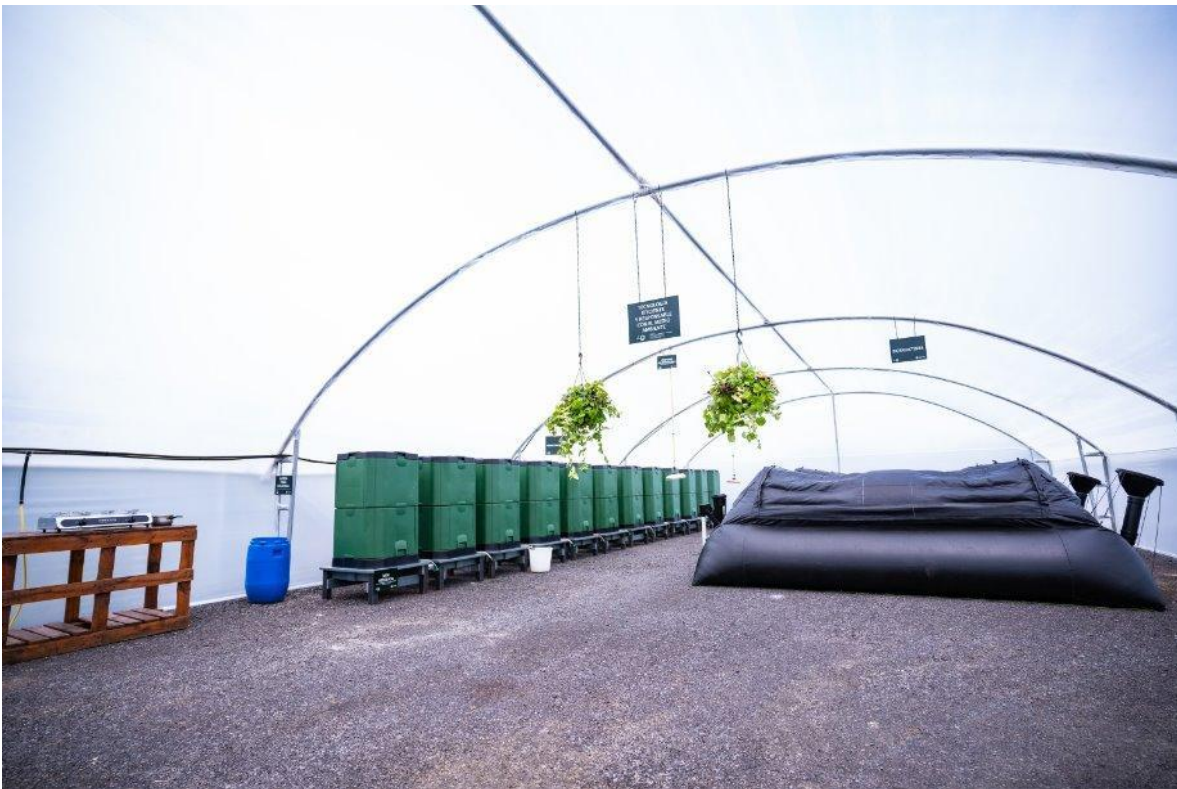
Biofábrica equipada con composteras y biodigestores
